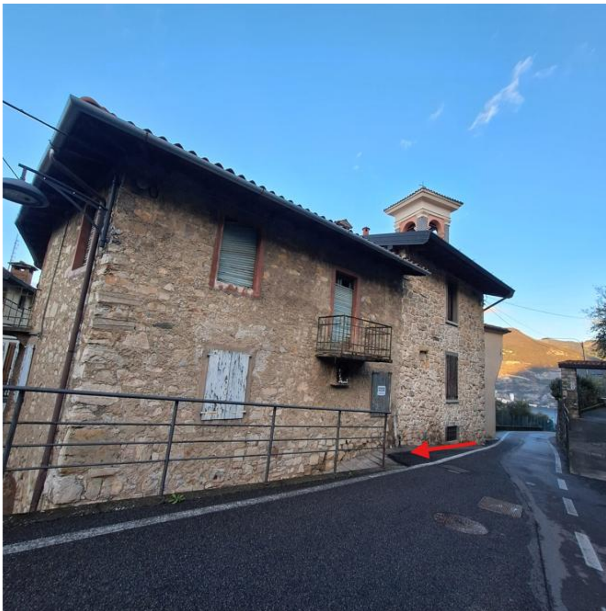
Fotografia 2 – Vista del percorso in corrispondenza degli edifici e della curva.
