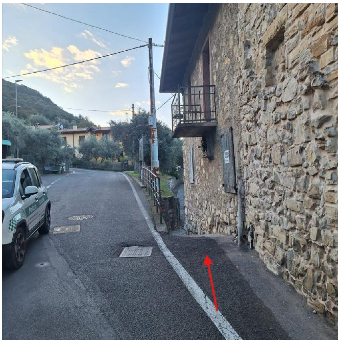
Fotografia 3 – Dettaglio dell'accesso e del passaggio laterale.
